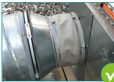
3 : Manchette correctement raccordée avec colliers de serrage
