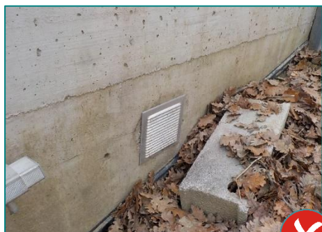
2 : Prise d'air à proximité du sol et donc des poussières
