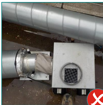
1 : Manchette pliée car mauvais alignement entre le caisson et le conduit
