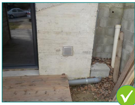
1 : Prise d'air protégée et éloignée des sources de pollution
