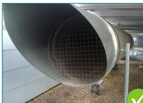
3 : Prise d'air protégée par une grille
