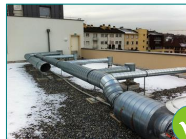
3 : Porte d'accès et cheminement en toiture terrasse
