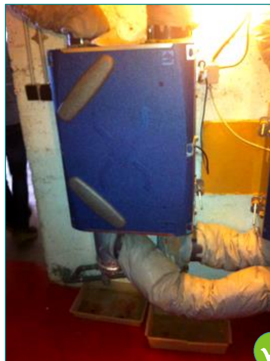
2 : Caisson de ventilation double flux isolé installé dans un volume non chauffé et non isolé
