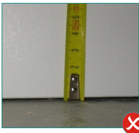
2 : Détalonnage insuffisant
