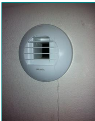
4 : Bouche d'extraction hygroréglable avec cordelette
