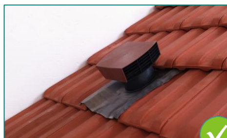
2 : Sortie de toiture correcte
