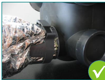
2 : Raccordements correctement réalisés avec colliers de serrage
