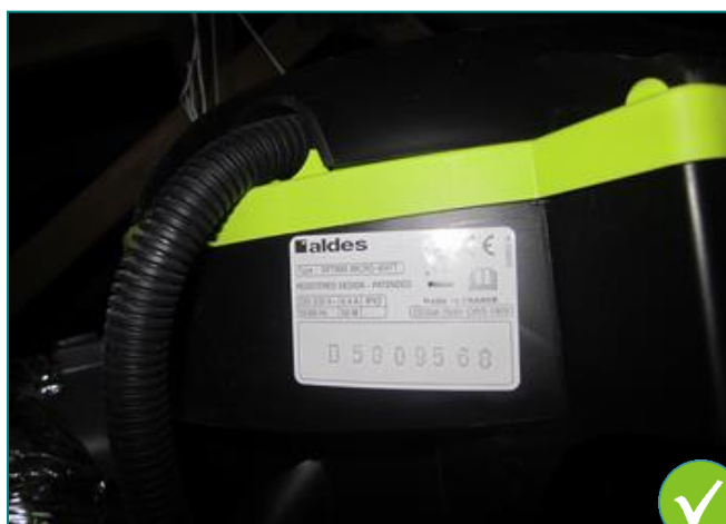
1 : Références lisibles sur une étiquette de caisson de ventilation d'une maison individuelle
