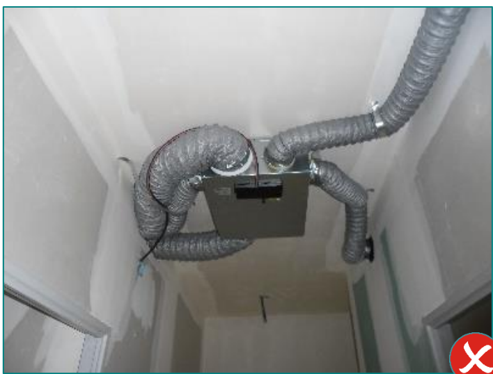
3 : Coudes importants directement au niveau des raccordements sur le caisson de ventilation en maison individuelle
