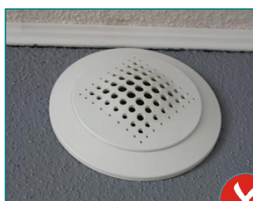
2 : Bouche collée à une paroi
