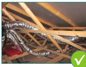
1 : Conduits souples correctement mis en œuvre (pas d'écrasement ni de coude supérieur à 90°)
