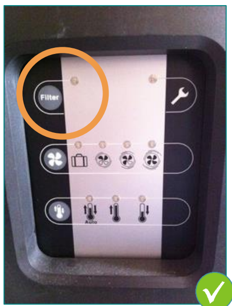
1 : Alarme de filtres identifiée par « Filter »
