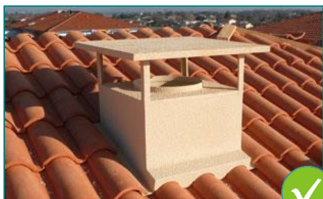
1 : Sortie de toiture correcte
