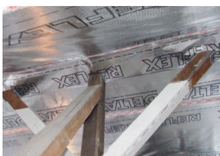
Rénovation en cours Pose du pare-vapeur DELTA®
